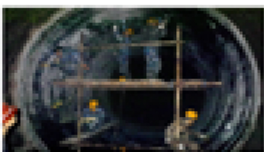
粘贴CFRP
